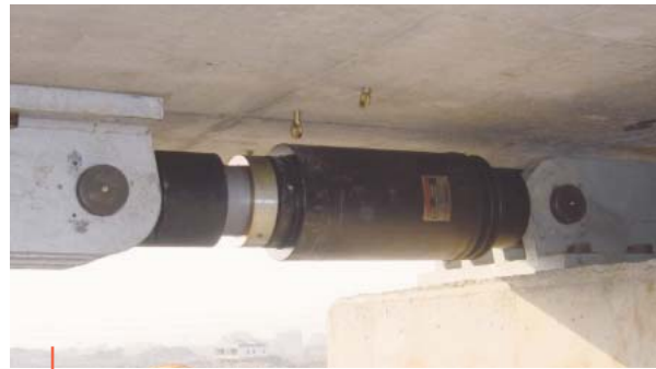
Bloqueadores / Shock transmission unit
