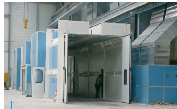
Nova unidade de pintura 31 x 8 m = 250 m 2 New painting system unit 31 x 8 m = 250 sqm
