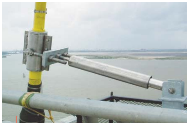
Amortecedores viscoelásticos para cabos tensionadores de pontes Viscous dampers for cable stays
