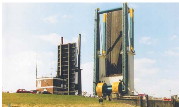
Ponte móvel de Estesperrwerk (Alemanha) Hastes com revestimento KERADOUCE® 2 Cilindros hidráulicos DA 500 x 360, Curso 10 600 mm 4 Cilindros hidráulicos DA 460 x 280, Curso 7 700 mm 2 Cilindros hidráulicos 63 x 36, Curso 320 mm 4 Cilindros hidráulicos 100 x 70, Curso 500 mm 4 Cilindros hidráulicos 100 x 70, Curso 1 600 mm
