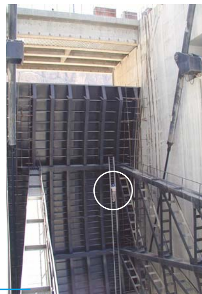
10 cilindros hidráulicos para comportas radiais DA 400 x 160, Curso 17 500 mm com hastes com revestimento KERADOUCE®
